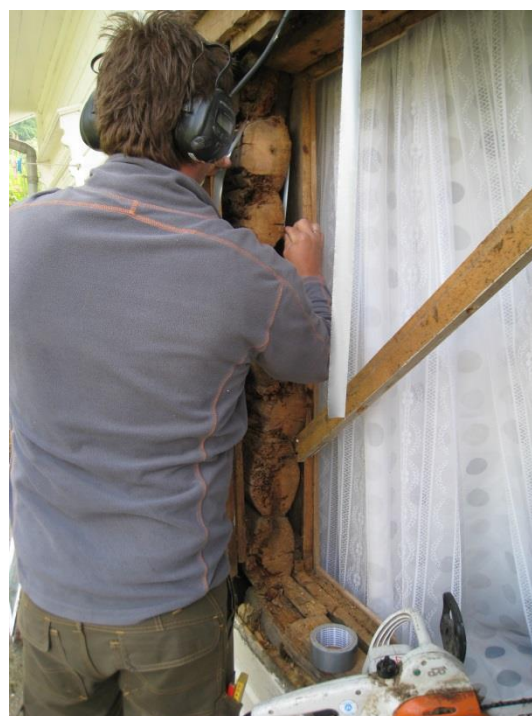
Figur 2: Udtagning af skiver fra vinduesrammen på husets nordside.
