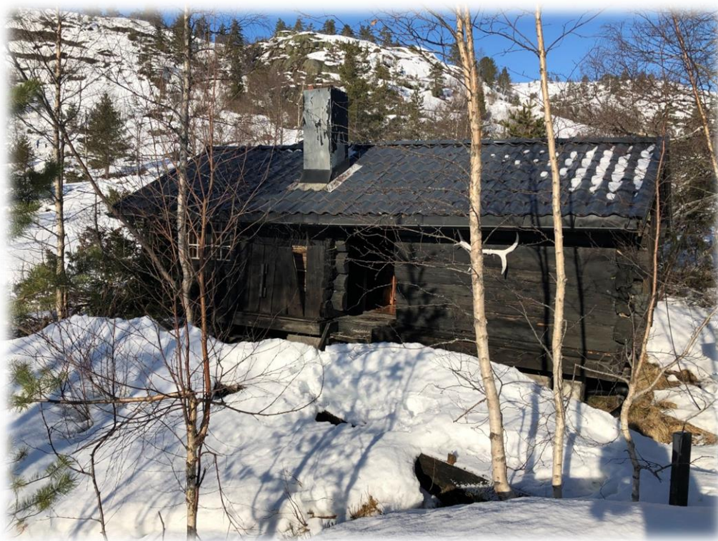
Figur 2 dagens situasjon med laftekassen fra 1. etasje plassert lengst mot vest og 2. etasje mot øst
