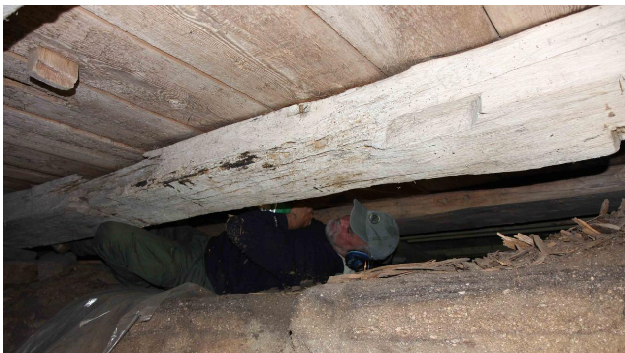
Helge Paulsen udtager boreprøve af bjælke nr. 2 under gulvet i skibet i Harkmark kirke. Bemærk udstemninger mm., som viser at bjælken har været anvendt til andet før den er brugt som gulvbjælke. Forsidefoto viser Helge Paulsen udtage boreprøve fra bjælke nr. 1.
