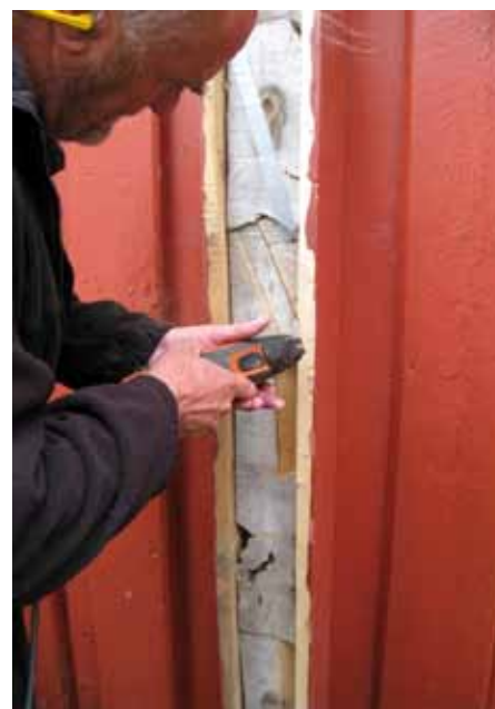
Figur 1. Prøverne udtages fra vægstokke i form af kile.
