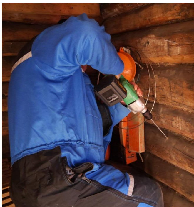
Figur 2: Prøvetagning med ”Berlinerbor”.
