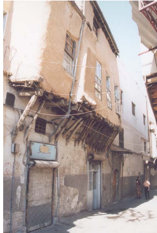
Abbildung 7 Beispiel einer etwas älteren Ausgabe, Haus in Damaskus, mit ‚Erker‘ aus Pappelholz und Lehmziegeln.
