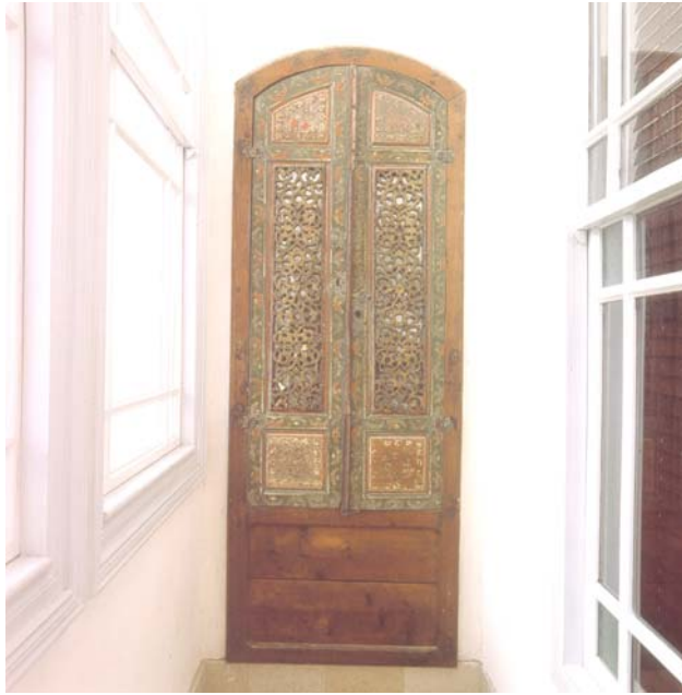
Abbildung 14 Im 1. Stock des Westflügels, am Nordende des Flurs, befindet sich ein Wandschrank. Dieser Schrank besitzt ein sehr kunstvolles, aus Zypressenholz gefertigtes, Schnitzwerk. Proben 26 und 27.
