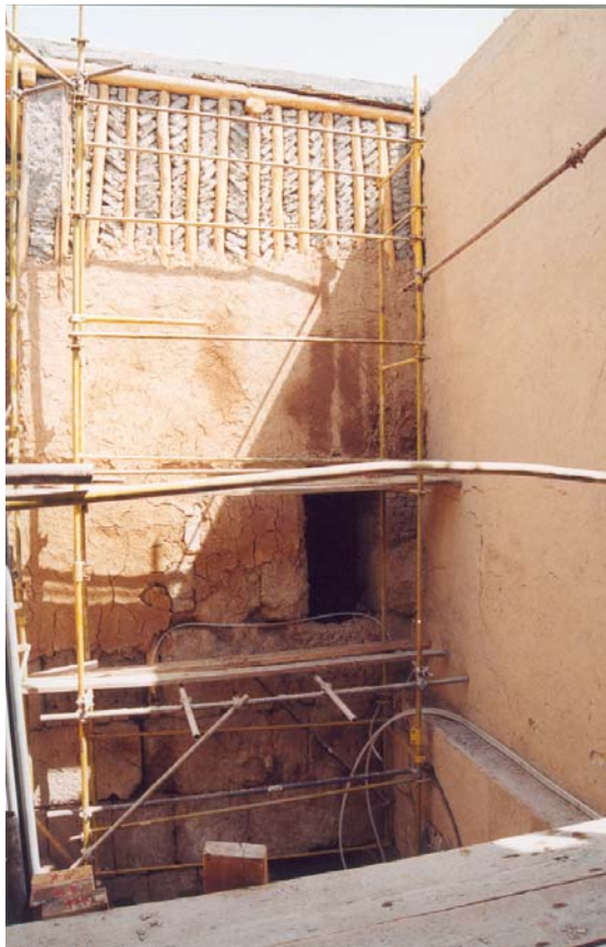
Abbildung 2: Neue Lehmziegelwand im Aqqad-Haus. Pfosten und Balken aus Pappelholz.
