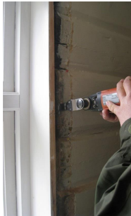
Figur 1: Delskiver udtages fra den gamle tømmerkerne fra vindueskarmen.
